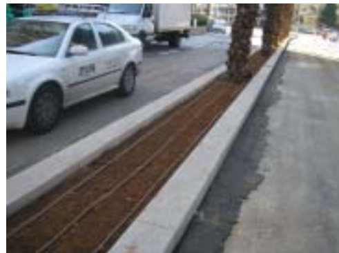
מערכת השקיה מוכנה לכיסוי אדמה גננית והנחת דשא, רחוב אבן גבירול, תל אביב
