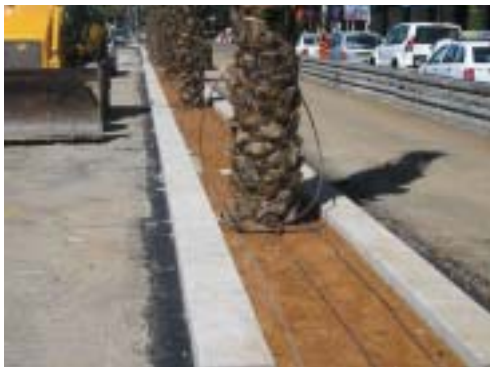
מערכת השקיה מוכנה לכיסוי אדמה גננית והנחת דשא, רחוב אבן גבירול, תל אביב
